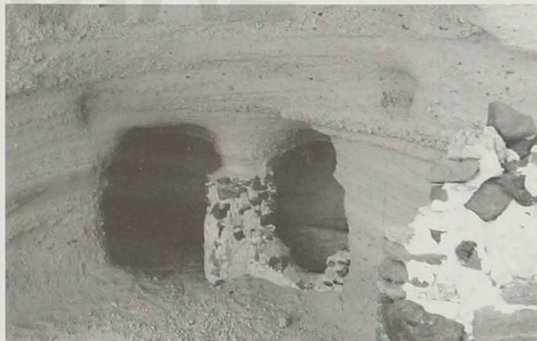
Βόθωνας. Ενίσχυση και σταθεροποίηση μιας φυσικής κολώνας με περιτοίχιση
